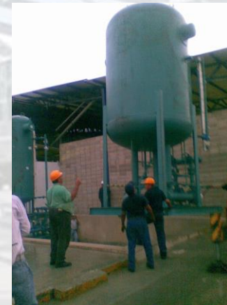
INSTALACION TANQUE AMONIACO. PLANTA PLUMROSE, CAGUA, EDO ARAGUA
