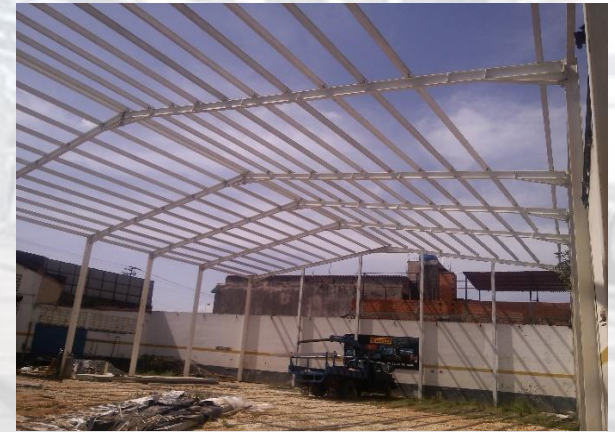
ESTRUCTURA BODEGA METALICA NEUMATICOS VALENCIA, C.A.
