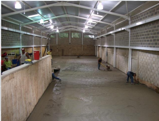
ESTRUCTURA BODEGA CON PUENTE-GRUA AGROCAUCHOS LA SOLUCION, C.A.
