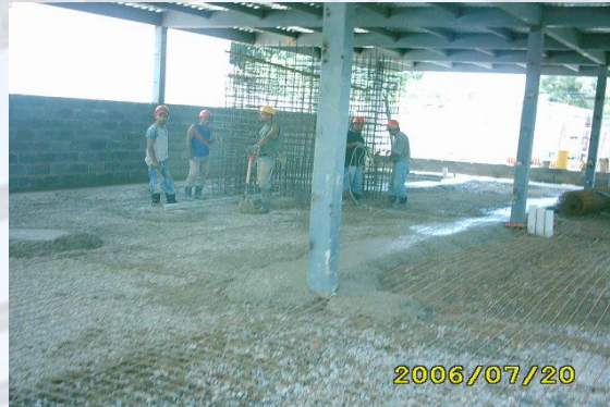
ESTRUCTURA METALICA SUCURSAL BANFOANDES EL PAO.EDO. COJEDES,
