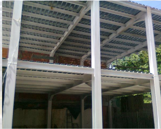
EDIFICIO ESTRUCTURA METALICA DISTRIBUIDORA RIESE, C.A.
