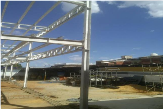
ESTRUCTURA METALICA TECNOCAUCHOS EXPRESS, C.A.
