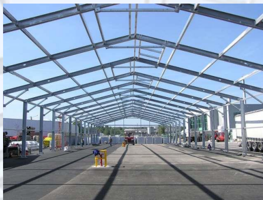
GALPON INDUSTRIAL Y OFICINAS SERVICIO CARABOBO (INTERIOR). SAN DIEGO. VALENCIA
