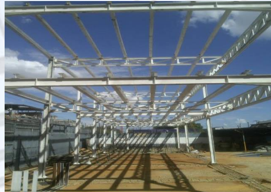
ESTRUCTURA METALICA TECNOCAUCHOS EXPRESS, C.A.
