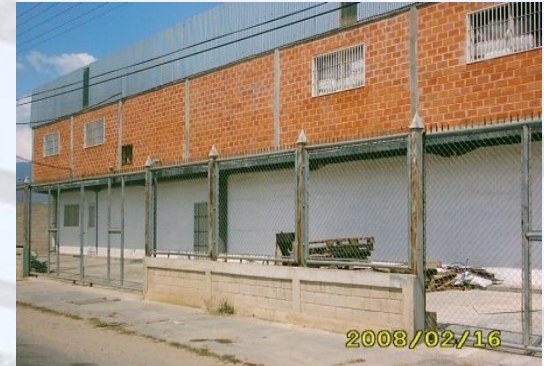
GALPON INDUSTRIAL Y OFICINAS SM CONSULTORES, VALENCIA
