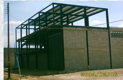
ESTRUCTURA METALICA EN CONSTRUCCION LOS JARALES, VALENCIA
